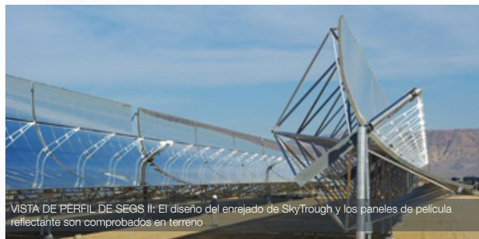
VISTA DE PERFIL DE SEGS II: El diseño del enrejado de SkyTrough y los paneles de película reflectante son comprobados en terreno
